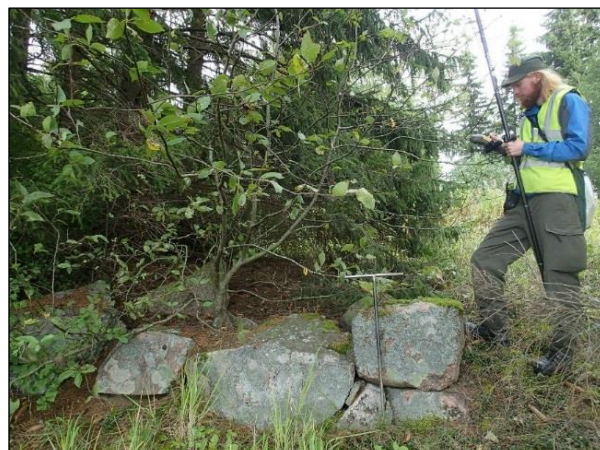
Rakennuksen perustus R1.
